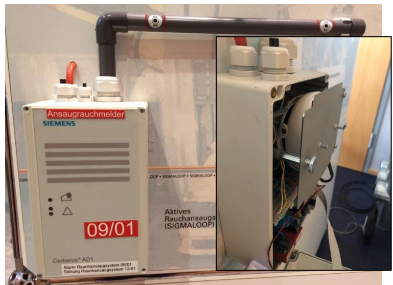
Abb. 28: Geöffneter Ansaugrauchmelder
