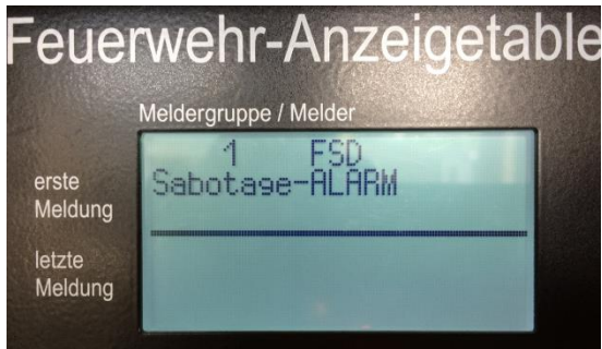
Abb. 34: Anzeige Sabotagealarm
