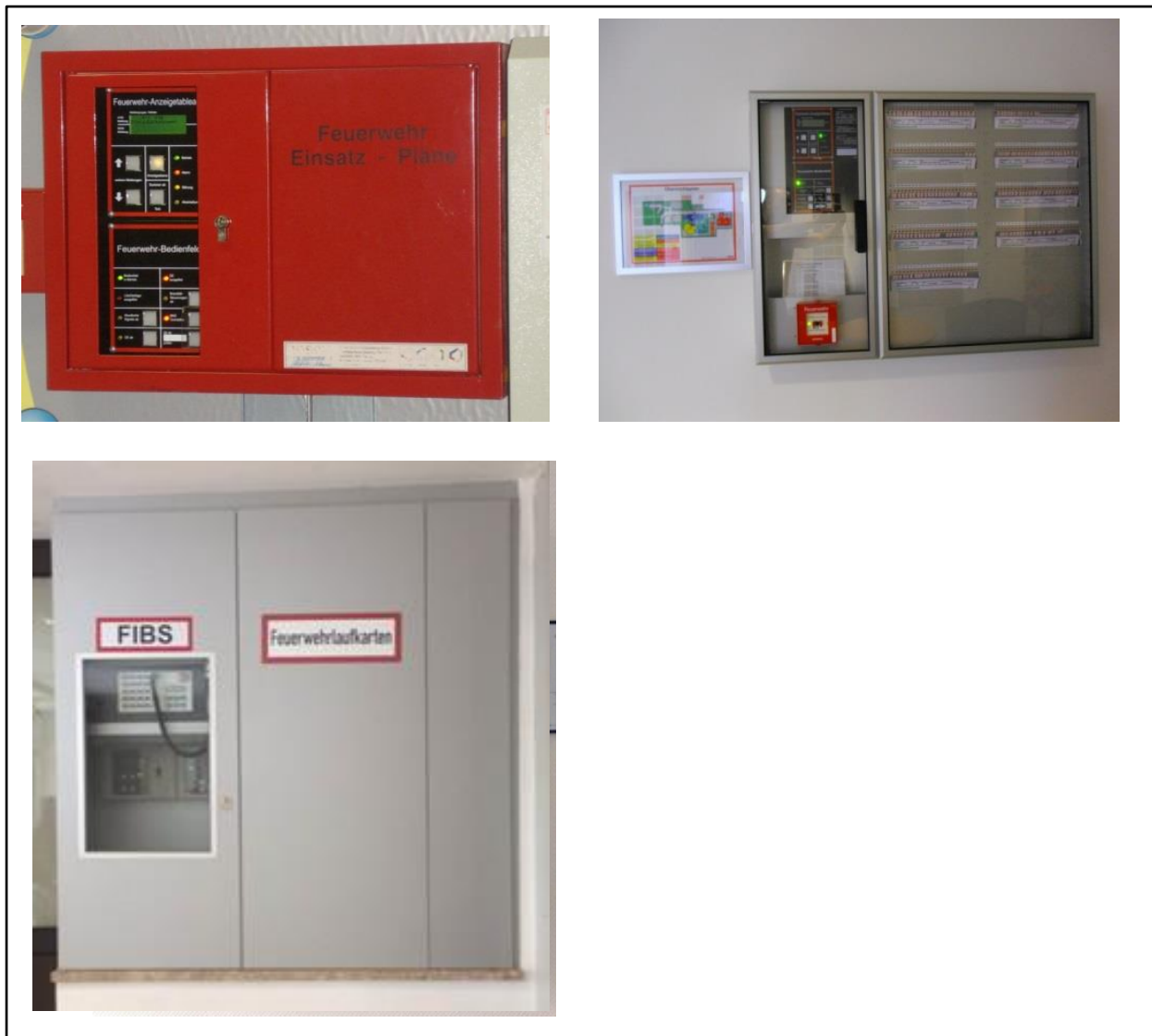
Abb. 13: Verschiedene Ausführungen der Ables- und Bedieneinrichtung
